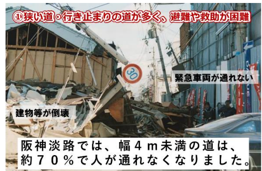
阪神淡路大震災の様子【写真：神戸市】
